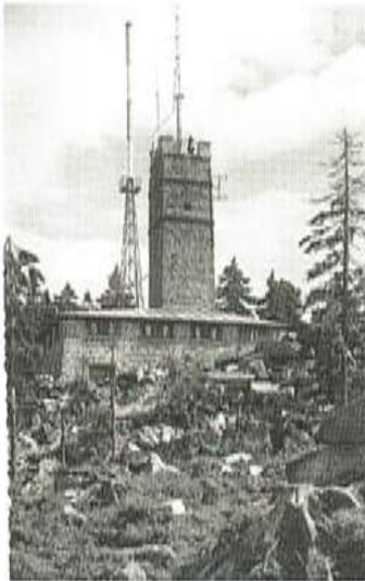
*Der Asenturm trug um 1950 eine Funkantenne, im Hintergrund stand ein hoher stählerner Sendemast, der Vorgänger des BR-Sendeturms (FGV-Fotoarchiv Jörg Hüttner)*
