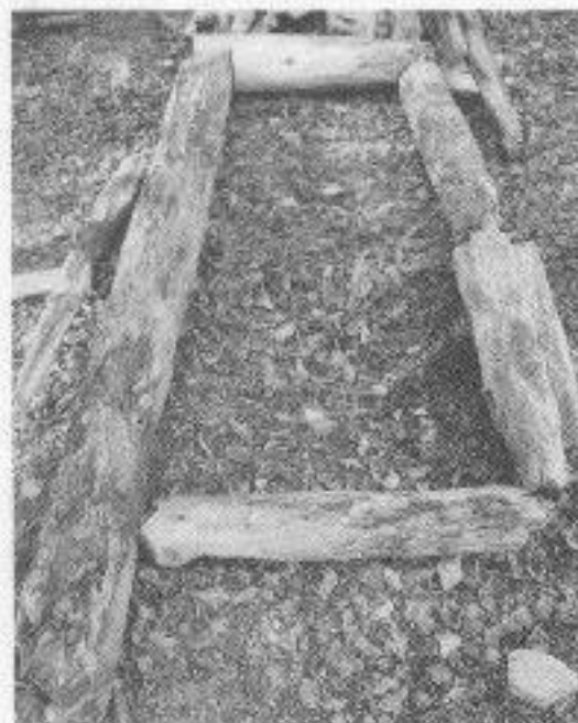
Bei der Freilegung des Stollens geborgenes Grubenholz aus dem Jahr 1723; derartige „Türstöcke“ dienten zusammen mit Holzschwarten zur Aussteifung des Stollens
