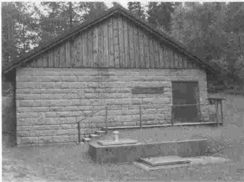
**Im Hochbehälter „Am Hügelfelsen“ wird das Trinkwasser aus dem Ochsenkopfgebiet seit 1985 gesammelt und mittels einer Entsäuerungsanlage aufbereitet.**
